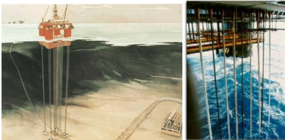
Figura 1. Plataforma tipo Tension Leg. Observa-se a estrutura dos componentes cilíndricos tais como os tubos ( risers ) que levam a produção do poço petrolífero para a superfície (Nishimoto (1997)).
